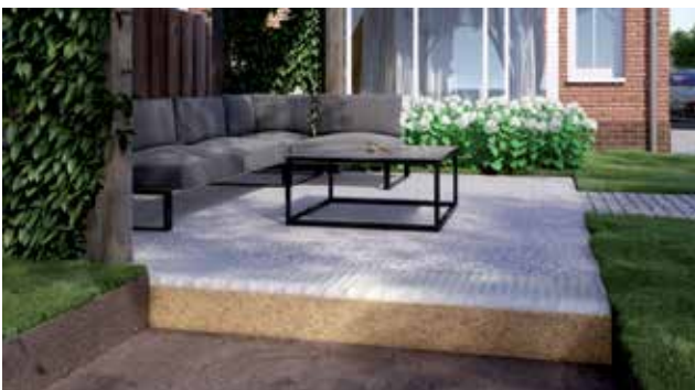
05. Infiltratie door middel van halfverharding.
