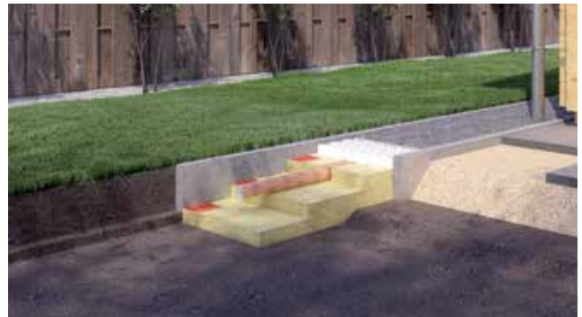
04. Infiltratie in een brede opvanggoot langs aanbouw of veranda.
